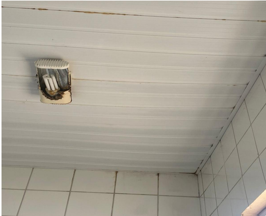
imagem 02: forro com efeito “selado” pelo peso dos dejetos de morcegos e cupins
